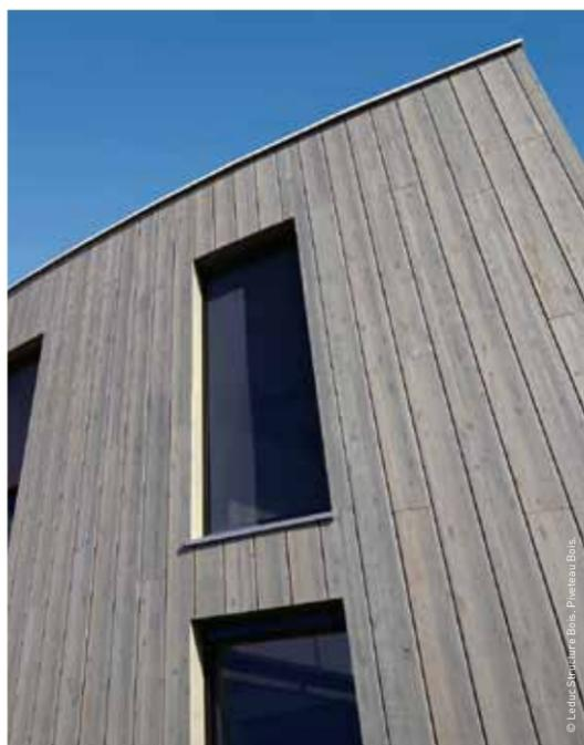
Bardage avec finition (lasure semi-transparente).
